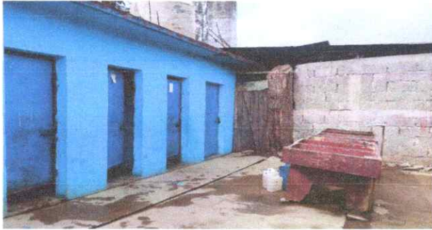
Foto 1: Reparación área de baños y lavamanos
