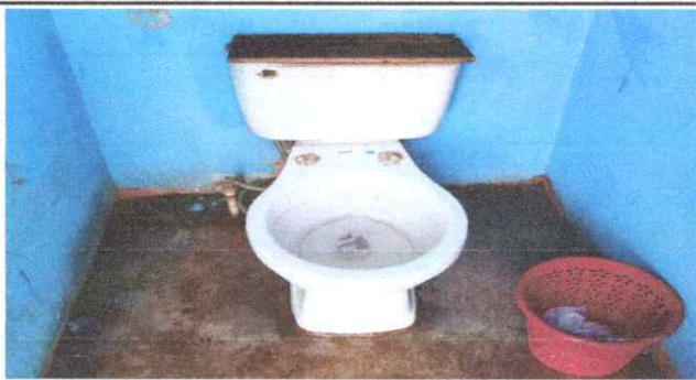
Foto 3: Sustitución de sanitarios
