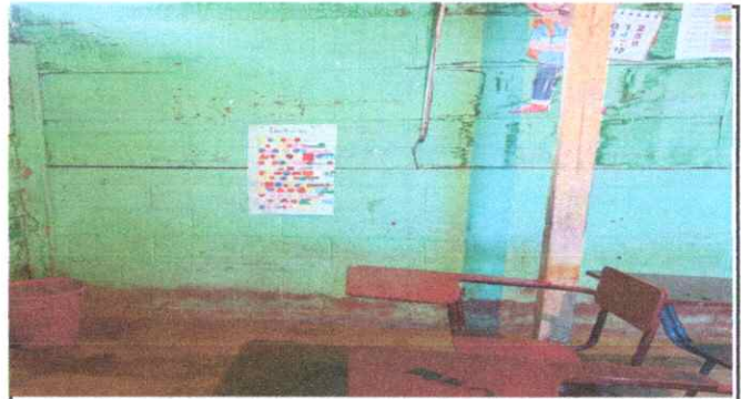
Foto 4: Reparación a paredes de modulos 1 y 2
